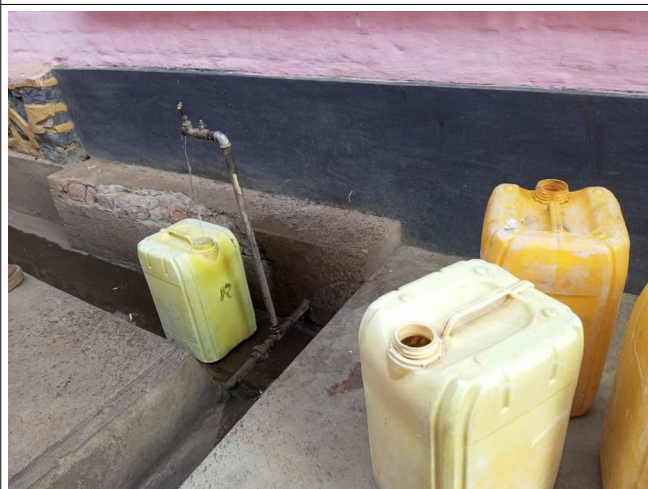
Zapfstelle an der Außenwand von ProKaMu
